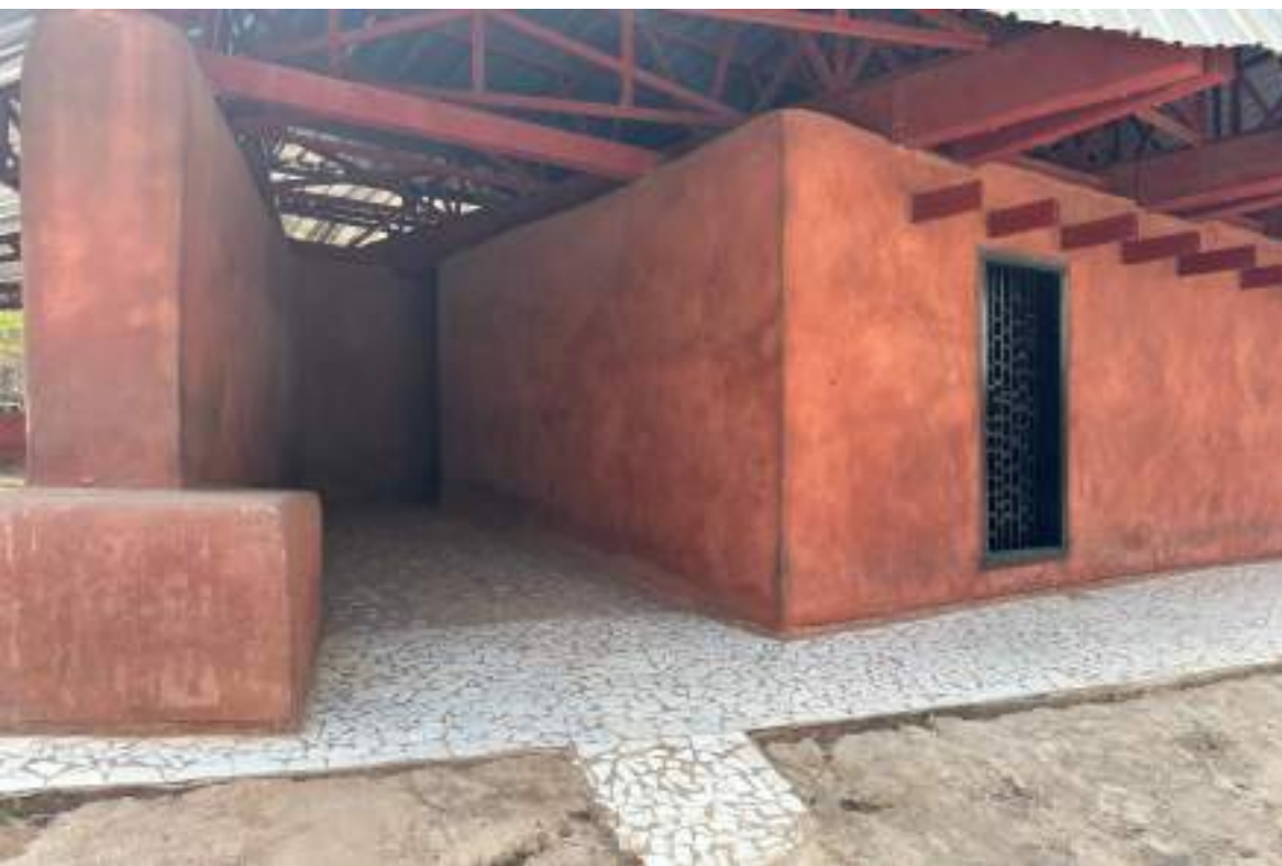
La costruzione con i sacchi, prima della finitura
